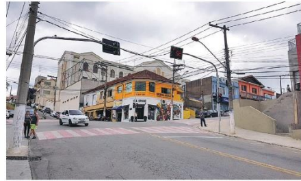
Equipamento foi instalado em cruzamento considerado de pouco movimento pelos franco-rochenses
